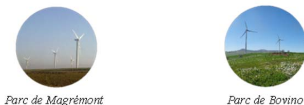
Figure 6 - Exemples de réalisations
